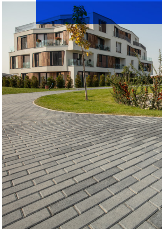
Klasiko® 6 sivá Bytový komplex, Malinovo
