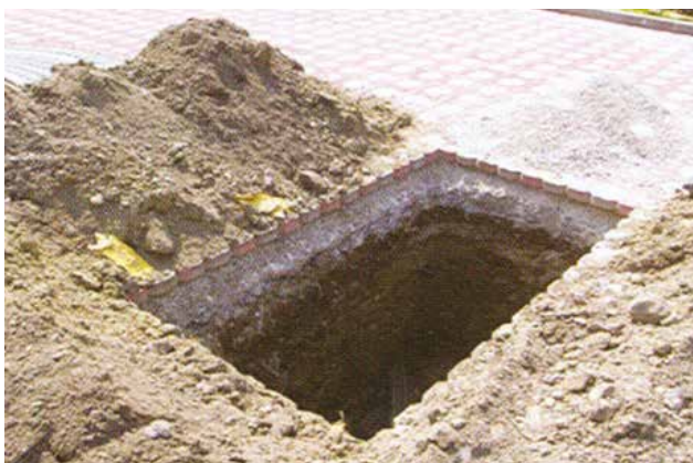
⬆ Felbontott térkő burkolat – a bontás során nem keletkezik hulladék
