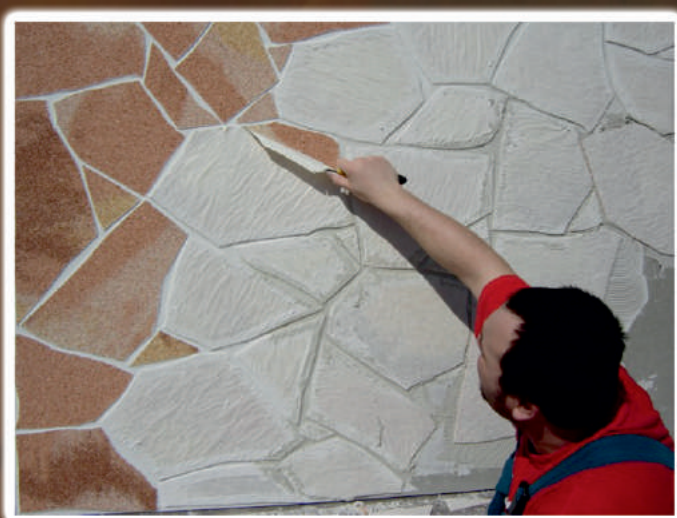
6. A védőfólia eltávolítása fugázás után.
