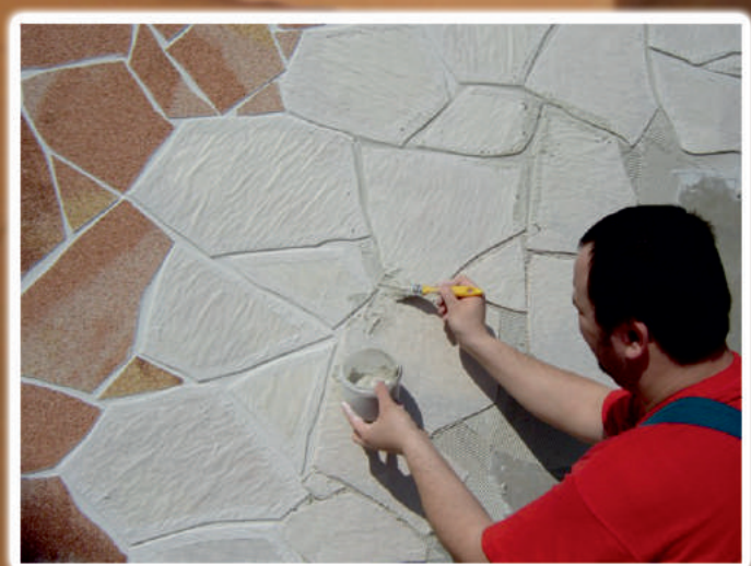
5. A hézagok kifugázása, a csemperagasztó maga a fuga anyag.
