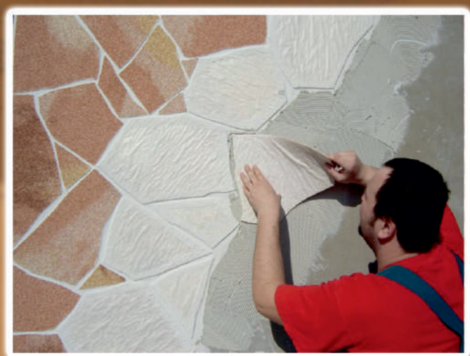
3. Véletlenszerű illesztés. Ragasztóba ágyazás a lap teljes hátfelületének érintkezésével!!
